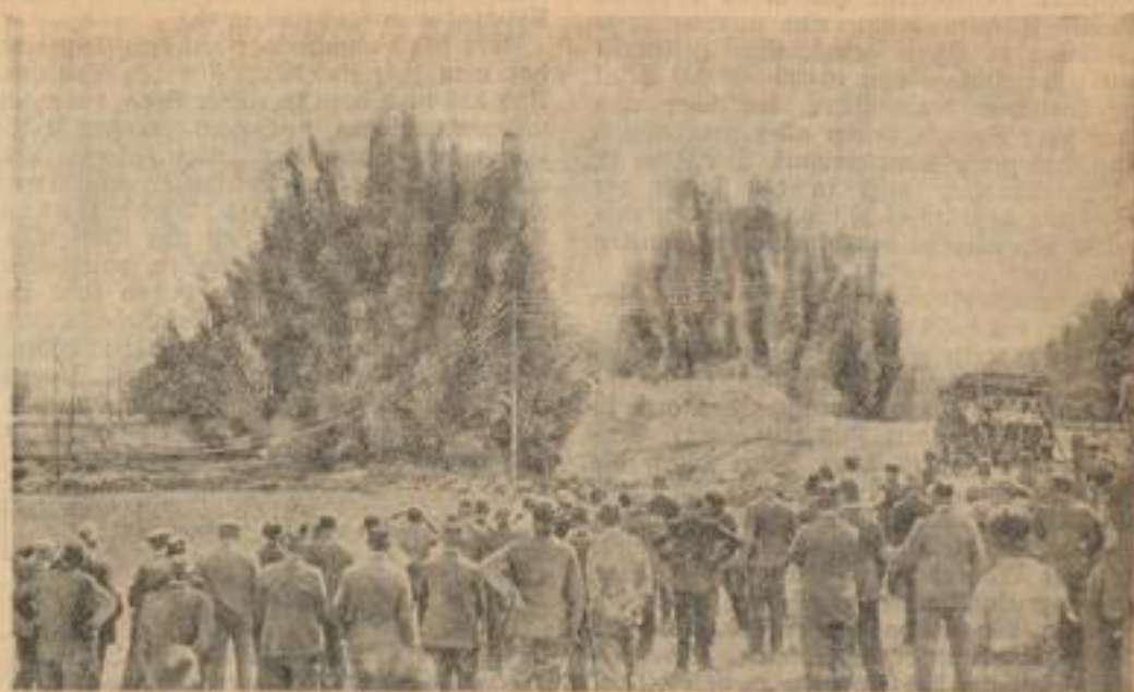
Ein Moor flieg in die Luft. An der Reichsautobahn Berlin-Frankfurt (Oder) wurde eine große Moorsprengung vorgenommen, die wohl die erste ihrer Art ist. Der Damm der Reichsautobahn führt an einer Stelle durch ein großes Moor, das der Aufschüttung zunächst großen Widerstand entgegensetzte. Da an dieser Stelle Moortiefen bis zu 20 Meter gemessen wurden, hätten, um dem Damm einen Halt zu geben, ungeheure Massen ausgehoben werden müssen. Aus diesem Grunde schritt man zur Sprengung. Der Damm wurde aufgeschüttet, und die 4000 Kilogramm eingesetzten Sprengmittel drückten bei der Explosion das Moor zu beiden Seiten heraus, so daß sich der Fuß des Damms auf die feste Schicht unter dem Moor absetzte. Unser Bild zeigt den Augenblick der Sprengung. (Atlantic, R.)
