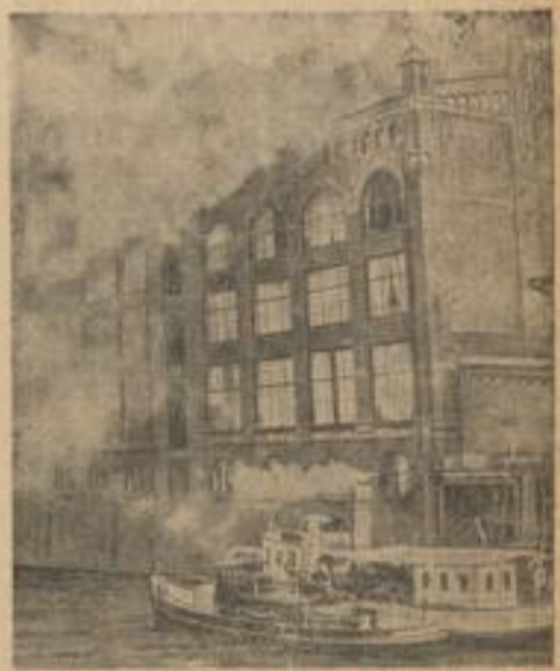
Feuer bei der Hapag. Im Proviantmagazin de Hapag am Reherstieg in Hamburg brach kürzlich Feuer aus, das den Dachboden des Gebäudes zerstörte. Den Bemühungen der Feuerwehr gelang es, ein Übergreifen des Feuers auf ein Filmlager zu verhindern. (Weißbild, R.)
