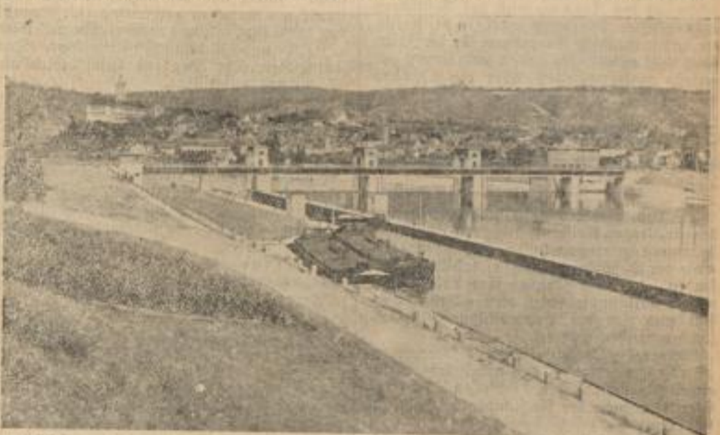
Die Brücke, die Württemberg mit Baden verbindet. Die vor kurzem eröffnete Horst-Wessel-Brücke mit dem Stauwehr in Gundelsheim a. N., die Württemberg und Baden miteinander verbindet. (Wolter, R.)
