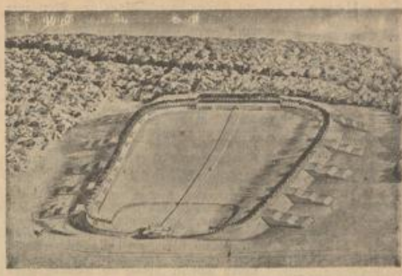
Der Bückeberg als Thüngshalle. Die große Kundgebungstätte des deutschen Bauernbundes wird unter der Oberleitung des Berliner Architekten Albert Speer, der auch die Nürnberger Parteibauten leitet, in großzügiger Weise ausgebaut. 400000 Kubikmeter Erde müssen bewegt werden, um einen Festplatz für 500 000 Teilnehmer zu schaffen, der von einem etwa 7 Meter hohen Wall umgeben sein wird.
