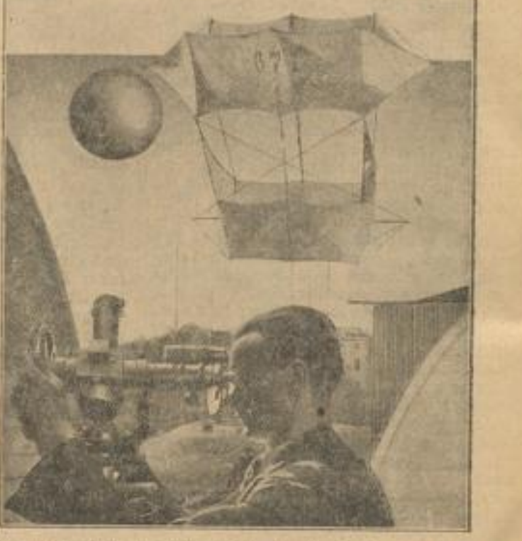
Die beiden wichtigsten Hilfsmittel für die Wetterkunde sind Pilotballon und Drachen. Die Pilotballone steigen viele tausend Meter empor — Sondenkonstruktionen sind sogar bis 35 000 m Höhe gestiegen — und werden beim Aufstieg durch Kontrollinstrumente genau in ihrem Flug verfolgt. Aus dem Flugverlauf erheben sich die Strömungen in hohen Luftschichten. Der Kammerdrachen, der automatisch schreibende Geräte trägt, wird ebenfalls in die hohen Luftregionen umgeschickt. Die von den Apparaten automatisch aufgenommene Angaben, z. B. die Temperaturkurve, werden ebenfalls zur Wettervorhersage ausgewertet. Aufn.: Wege.
