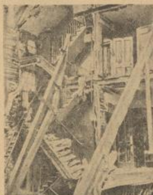
Sturm entblößt ein Haus
