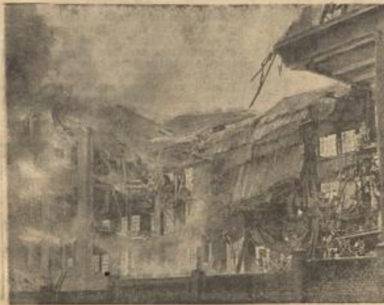
Das furchtbare Brandunglück von Wuppertal
