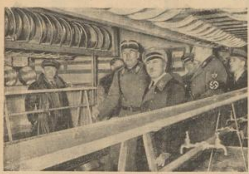
Dr. Ley bei den Autobahnarbeitern Reichsorganisationsleiter Dr. Ley stiftete dem neuen Arbeitslager Werbellin einen Besuch ab, in dem die Bauarbeiter der Reichsautobahn Berlin-Stettin untergebracht werden sollen. Unser Bild zeigt ihn mit Generalinspektor Todt bei der Besichtigung der Küche.
