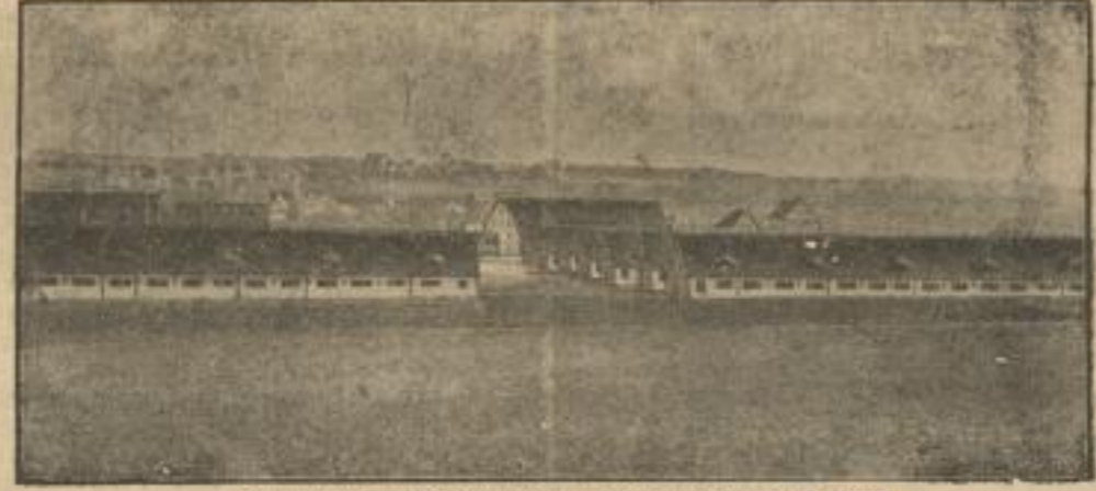
Gesamtsicht des ehemaligen Schutzhäftlagers Heuberg
