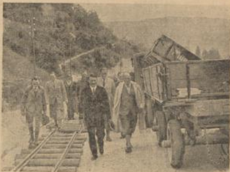
Der Führer auf der Alpenstraße. Reichsstatthalter Adolf Hitler besichtigte den Stand der Arbeiten an der zur Zeit im Bau befindlichen deutschen Alpenstraße, die von Lindau bis Berchtesgaden führt. Rechts von ihm der Generalinspekteur des Straßenwesens Dr. Todt, dazwischen Gruppenführer Brückner.
