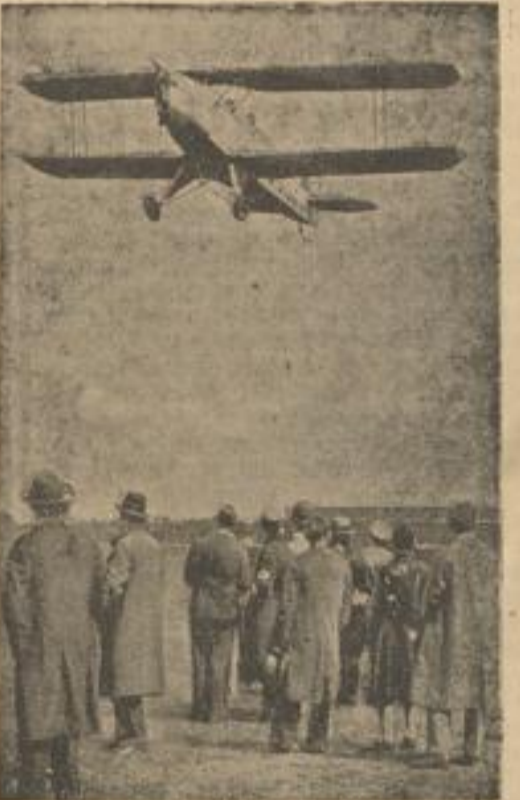
Ein neues deutsches Sportflugzeug Die Hitler-Flugzeugbau-GmbH. in Berlin-Börsenpark hat dieses neue Sport- und Sportflugzeug vom Typ „Jungmann“ herausgebracht. Es hat eine Spannweite von 7,50 Meter, ist mit einem 80 PS-Motor ausgerüstet und bietet Raum für einen Piloten und einen Passagier. Das Flugzeug ist für Kunstflüge geeignet.
