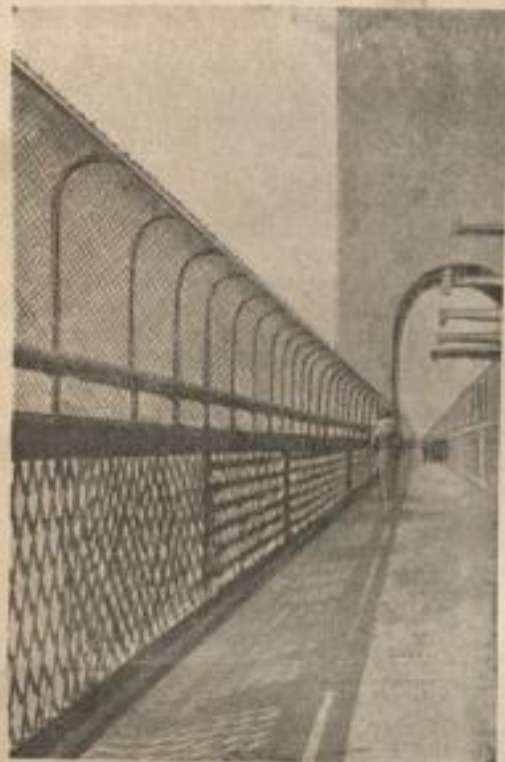
Brückenschutz für Selbstmörder Die Kielerbrücke über den Hafen von Sydney in Australien, von der sich seit ihrer Eröffnung im Jahre 1932 zahlreiche Selbstmörder hinuntergestürzt haben, soll jetzt einen Geländerschutz wie ihn unser Bild im Entwurf zeigt, erhalten. Das Geländer soll eine Höhe von drei Metern haben.
