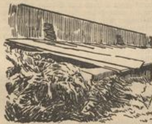
Verstärkte Gruben mit Bretterdeckel.
