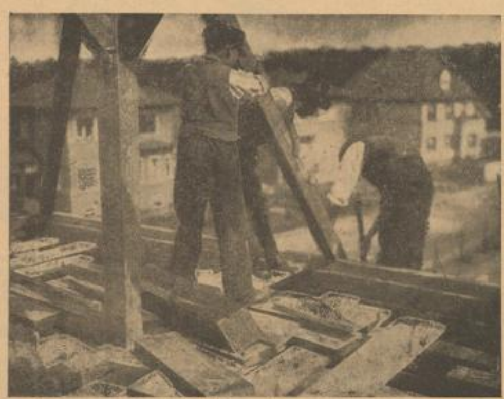
Das neue Haus ist aufgerichtet, nun, Maurer, decket und mauert aus!
