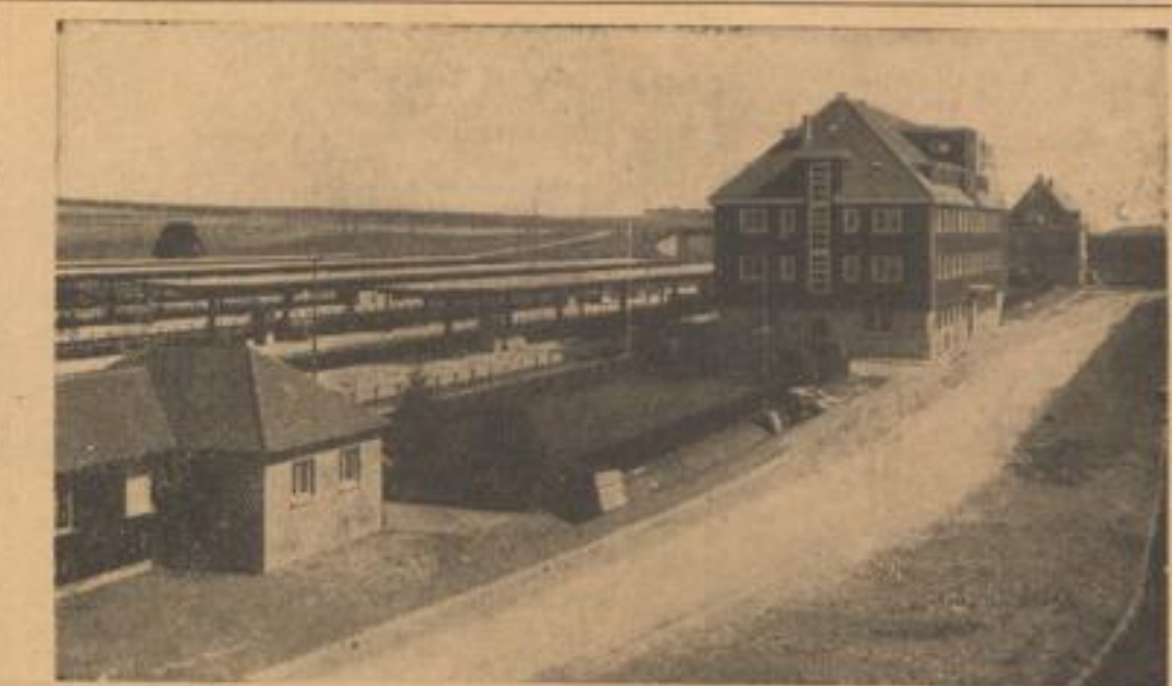
Die neue Bahnhofsanlage in Eutingen bei Horb
