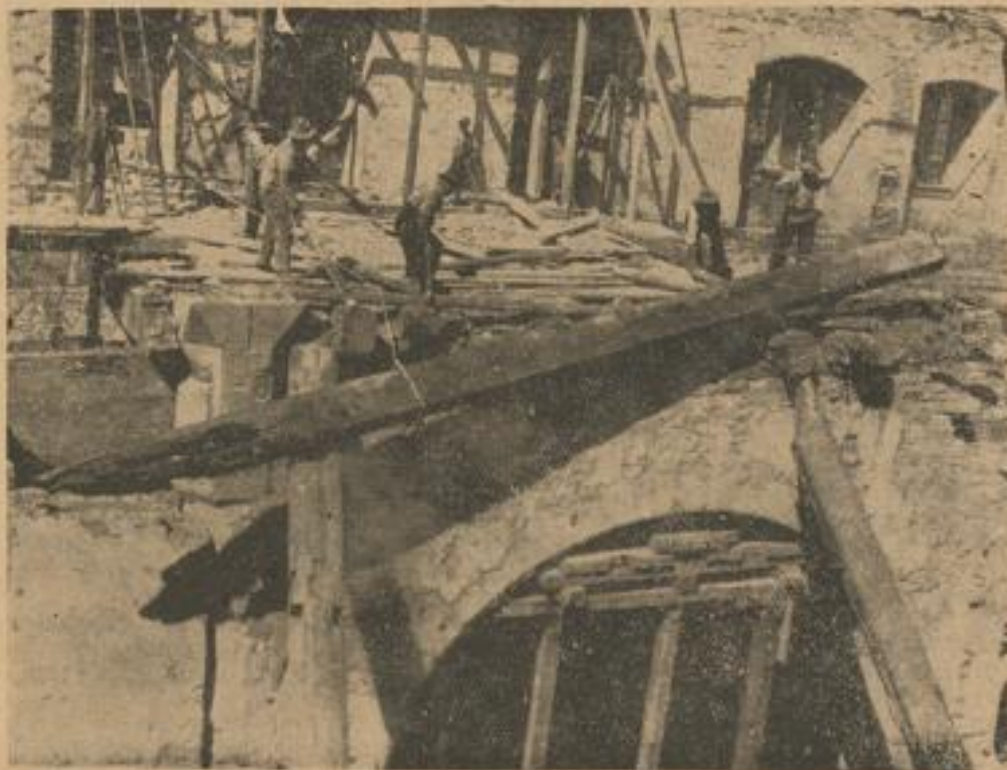
Unten: Schwieriges Absägen der 15 m langen Eichenbalken
