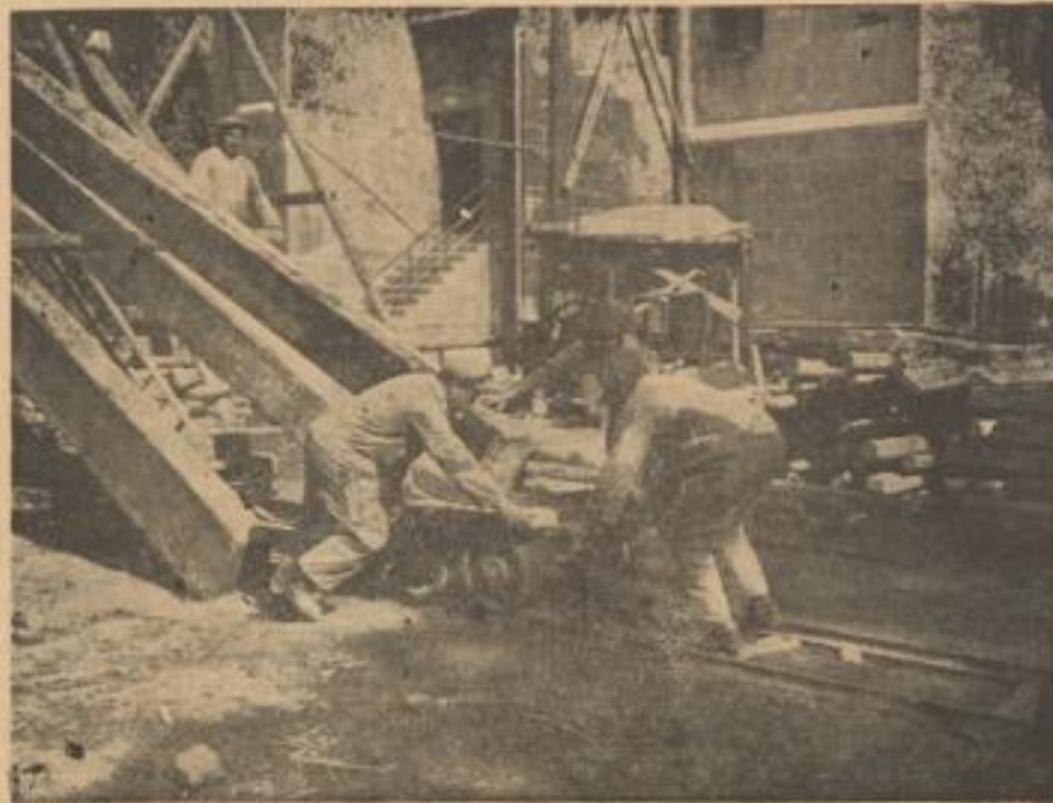
Abgebrochenes Gebälk wird abgeschleppt
