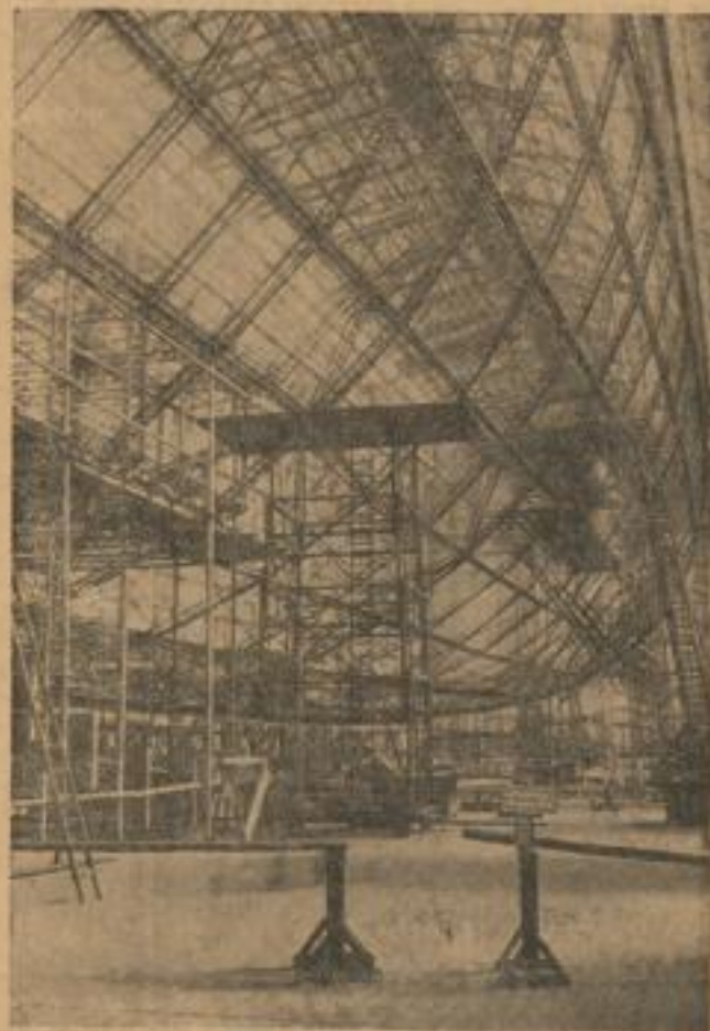
An der Wiege eines neuen Jenseits Das Aluminiumgerüst des „B 129“, der alle seine Vorgänger an Größe übertreffen wird, und der jetzt in der Halle in Friedrichshafen-Edwensfeld fertiggestellt wird.
