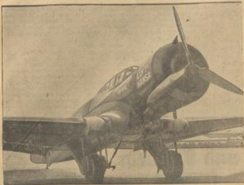
Ein neues Schnellflugzeug im deutschen Luftverkehr. Dieses Schnellverkehrsflugzeug — eine Junkers „Ju 50“ — ist jetzt von der Deutschen Luft Hansa in Dienst gestellt worden. Es handelt sich um einen Ganzmetall-Tiefdecker mit Doppelflügeln, dessen Fahrgestell während der Fahrt zur Verminderung des Luftwiderstandes und damit zur Erzielung einer höheren Geschwindigkeit — 285 Stundenkilometer — eingezogen werden kann.
