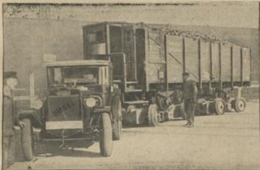
Das rollende Anschlußgleis der Reichsbahn Die deutsche Reichsbahngesellschaft hat jetzt das fahrbare Anschlußgleis eingeführt, wodurch die beladenen Güterwagen auf ein fahrbares Gestell gesetzt und von einer Zugmaschine bis vor die Bohrung des Empfängers gerollt werden können. Durch die Verwendung von 16 Hochlastreifen werden selbst Hindernisse von 20 Zentimeter Höhe erschütterungsfrei überwunden. Durch diese Neuerung werden das bisher notwendige mehrfache Umladen und damit Zeit und Mehrkosten erspart.
