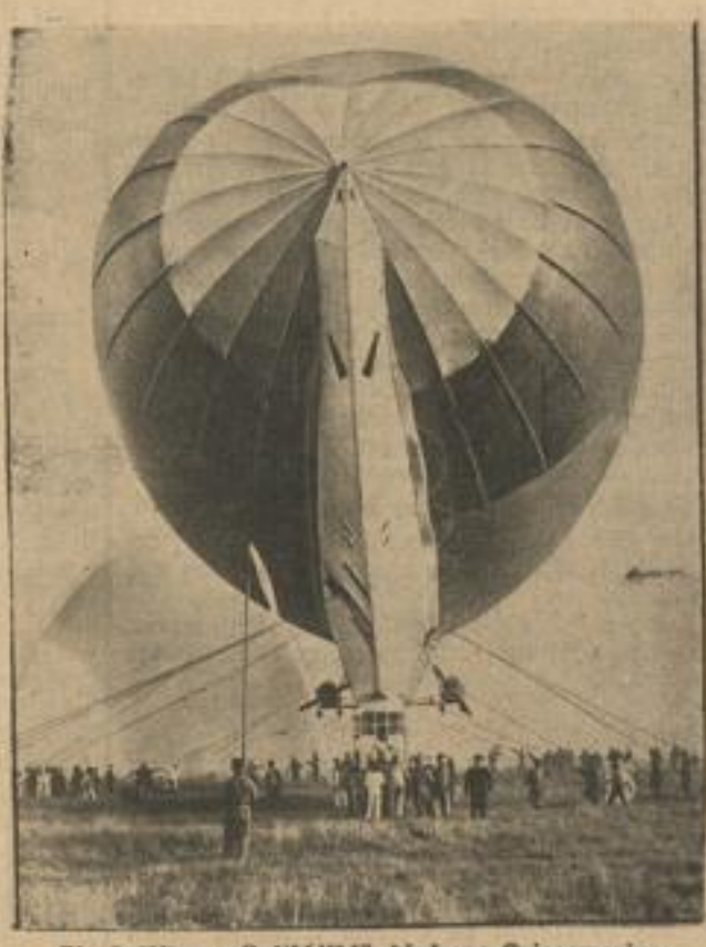
Ein halbstarres Luftschiff für die franz. Kriegsmarine wurde nach mehreren Jahren wieder übernommen. Rauminhalt: 10 000 cbm., Länge: 80 Mtr., Durchmesser: 16 Meter, Stundengeschwindigkeit 110 Km.
