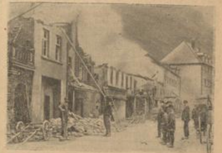
Großfeuer in Zell vernichtet sieben Wohnhäuser.
