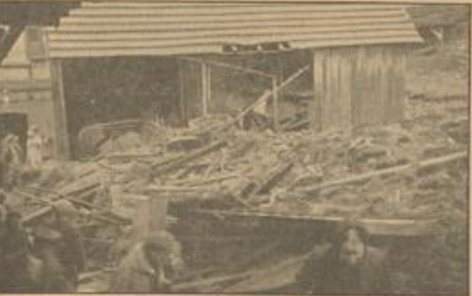
Verwüstungen in Sulz Oa. Nagold. Hagelkörner, Steine, Schlamm, Holz und Wagenteile bedecken teilweise bis zu den Dächern reichend (s. rechts oben) die Strassen.
