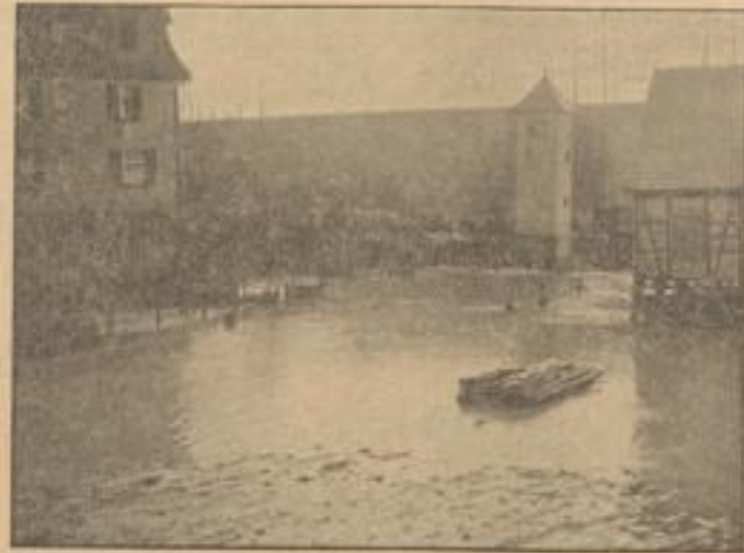
Die Ueberschwemmung vor dem Bahndamm l. d. Herrenbergerstraße
