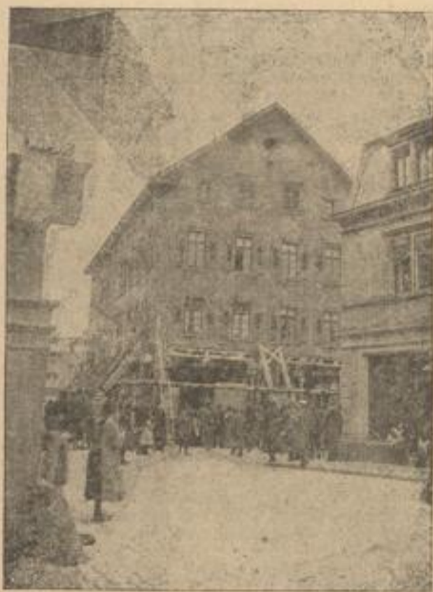
Der zerstörte „Hirs“ kurz vor ihrem Einsturz.
