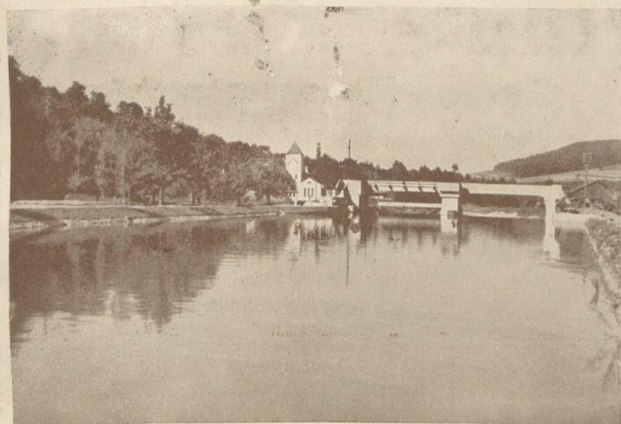
Das neue Wehr des Nagolder Elektrizitätswerkes (Gesamtansicht)
