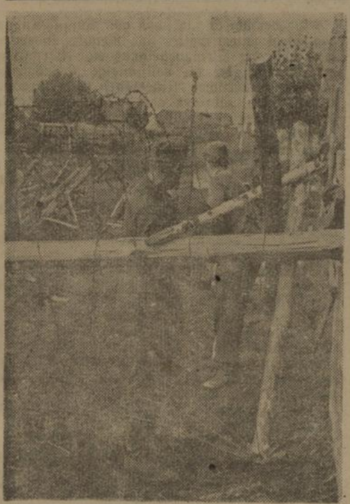
Der Brückenkopf soll eine Waffenspitze werden. Spanische Reiter werden zusammengebaut
