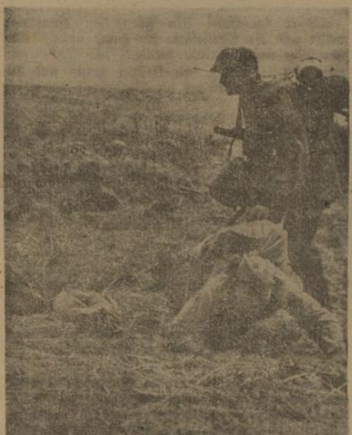
Einbruch in die feindliche Stellung
