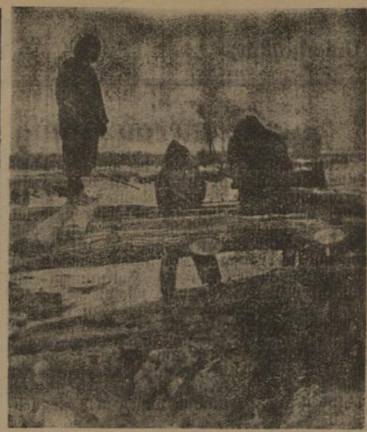
Panzerpioniere im Kampf gegen den Schlamm. Angangbare Straßen im Sumpfbereich des mittleren Dones werden von unseren Panzerpionieren durch kleine Brückenbauten passierbar gemacht (DR. Kaiser)
