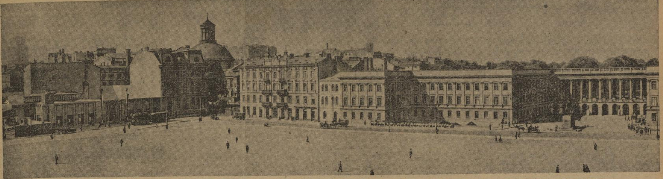
Der Mittelpunkt Warschaus, der Marshall-Pilsudski-Platz mit dem Generalstabsgebäude, Unter den Arkaden der Kolonnaden das Grab des Unbekannten Soldaten.
