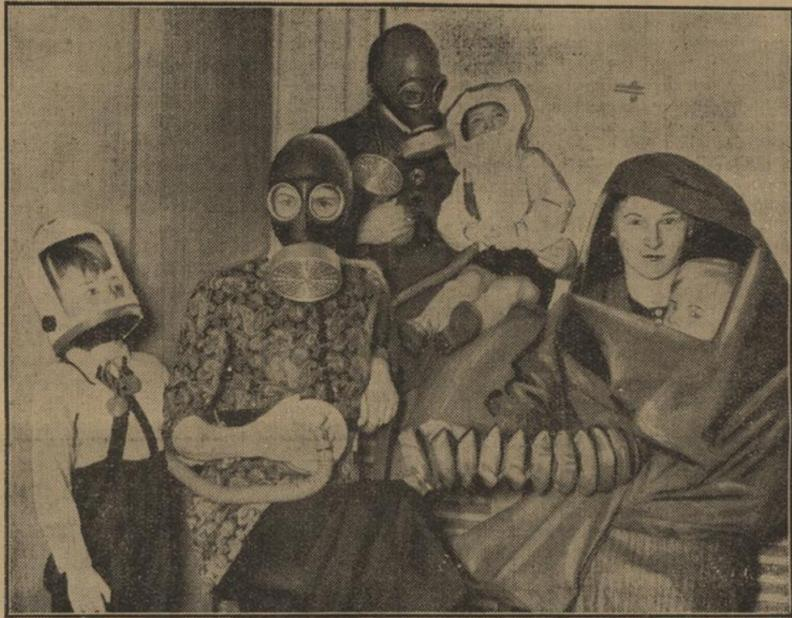
Die deutschen Gasschutzgeräte für Kinder. Neben der Volksgasmaske sind in Deutschland auch Gasschutzgeräte für Kinder entwickelt worden, deren leichte Handhabung besonders bemerkenswert ist. Unser Bild zeigt verschiedene Arten der neuen Geräte. Von links: Gasschutzhaube, Gasschutzjacke und eine gemeinsame Gasschutzjacke für Mutter und Kind. (Scherl, Bilderdienst.)
