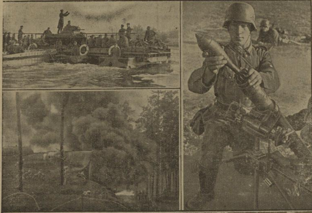
Unsere Wehrmacht arbeitet. Links oben: Eine Pontonfähre setzt einen Panzerwagen und Meldefahrer über. Unten: Pioniere gehen gegen befestigte Stellungen vor. Rechts: Ein Granatwerfer wird geladen
