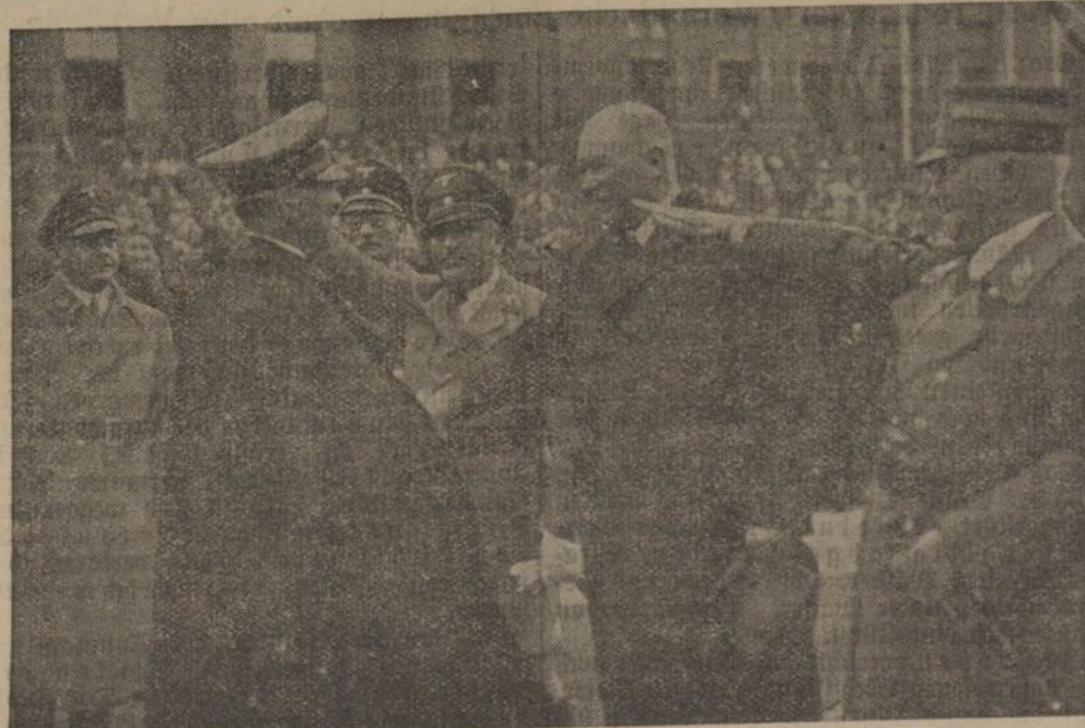
In Anwesenheit des Führers fand der erste Spatenstich zu den großen Bauvorhaben in der Hauptstadt der Bewegung statt. — Der Führer wird bei seiner Ankunft an der Baustelle von Reichsverkehrsminister Dr. Dörpmüller begrüßt. (Presse-Sothmann, Sander & Co.)
