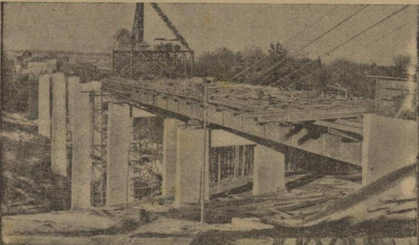
Neuer gewaltiger Brückenbau der Reichsautobahn. Ein weiteres gewaltiges Bauwerk im Zuge der Reichsautobahn München—Landesgrenze ist ein Talübergang zwischen Siegsdorf und Treisendorf bei Traunstein. Die Loitalbrücke überspannt hier in 308 Meter Länge die 42 Meter tiefliegende Talsohle, sechs Doppelturmpfeiler mit Stahlüberbau tragen das künftige Fahrband. (Atlantic, M)
