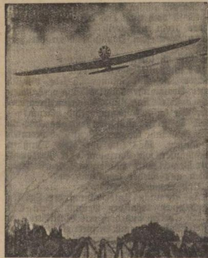
Das „kugelsichere“ Flugzeug. Die Vickers-Wellely-Werke in England haben dieses neue Kampfflugzeug herausgebracht, dessen Flügel waffelförmig unterteilt sind, so daß Kugelschläge kaum eine Beeinträchtigung der Flugleistung und der Flugsicherheit zur Folge haben. Sein Erfinder heißt Barnes Bailes. (Ewerl. Bilderdienst. 2.)
