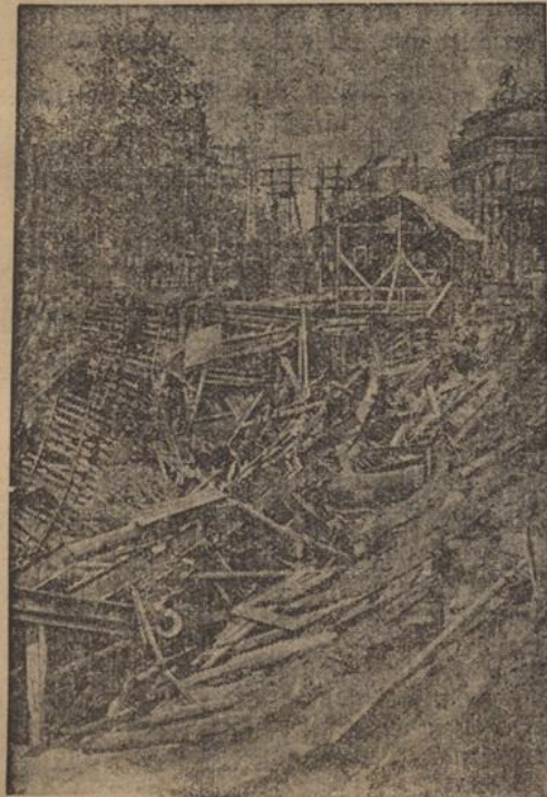
Das Einsturzungsunglück beim Bau der Nord-Süd-Bahn in Berlin. (Neuzeit-Zeitung, B.)
