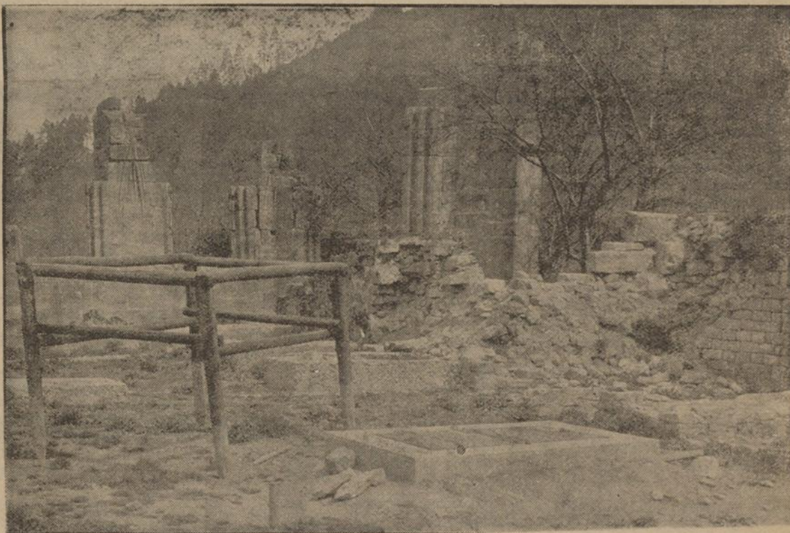
Keine Baustelle, sondern der Chor der einstigen Klosterkirche
