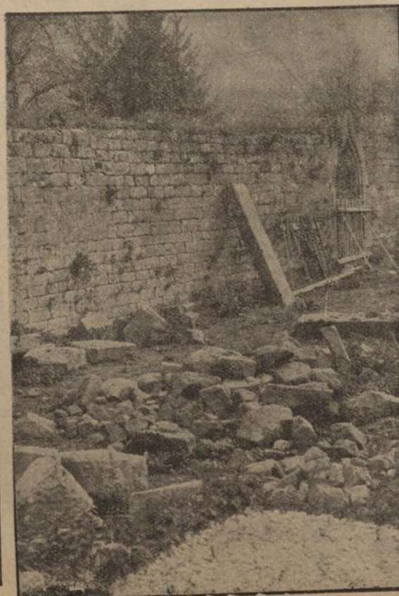
Links: Am nördlichen Kirchentor Schutthaufen, Gestrüpp, zerbrochene Grabsteine bedecken den Boden des Kircheninneren. Eines der schönsten nördlichen Tore ist durch einen häßlichen Zaun verschlossen und abgestützt. Rechts im Vordergrund einer der Betonsockel, die zur Markierung der früheren Säulen dienen sollen.
