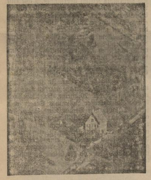
Das Föhrerhaus bei Frenndstadt vor dem Erdbeben
