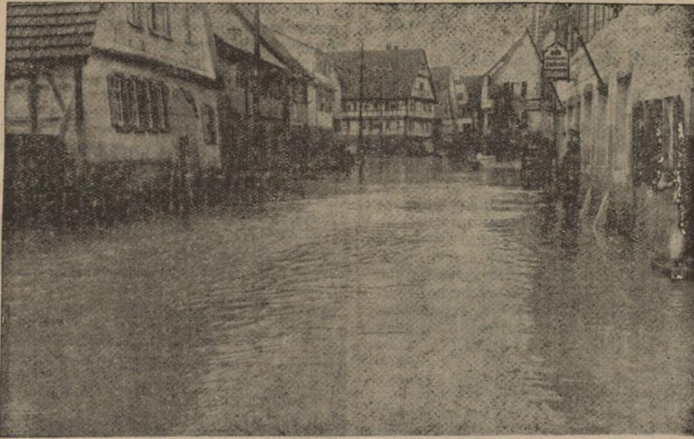
Fußhoch steht das Wasser in den Straßen von Großheppach
