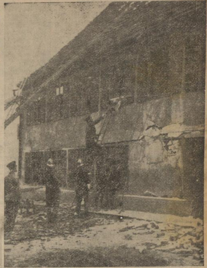
Die Rückseite des Schulgebäudes — Feuerwehrleute räumen das restliche Inventar aus
