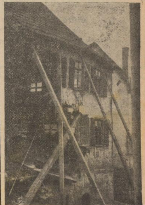
Der rechte Flügel des Schulgebäudes
