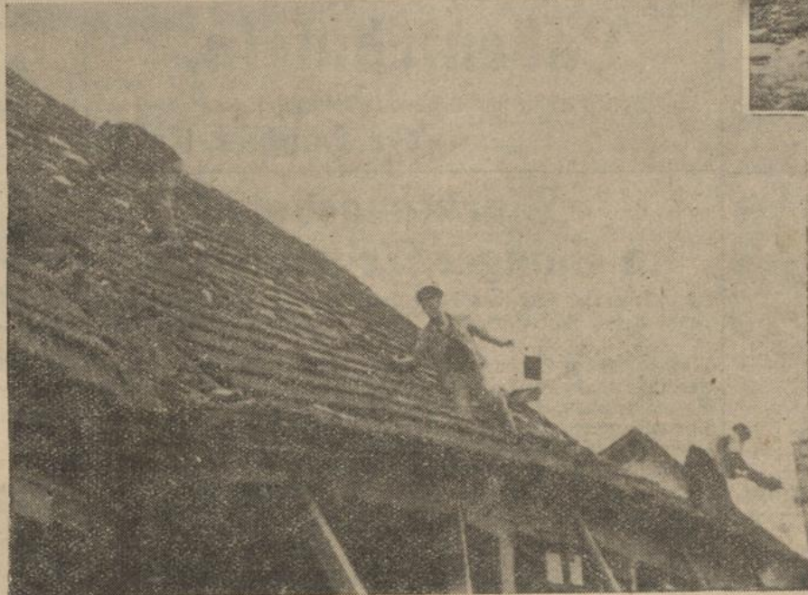
Wagemutige Feuerwehrleute decken unter Lebensgefahr das Dach ab
