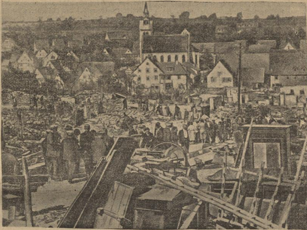
Unsere Aufnahme veranschaulicht einen Gesamtüberblick über die Brandstätte.
