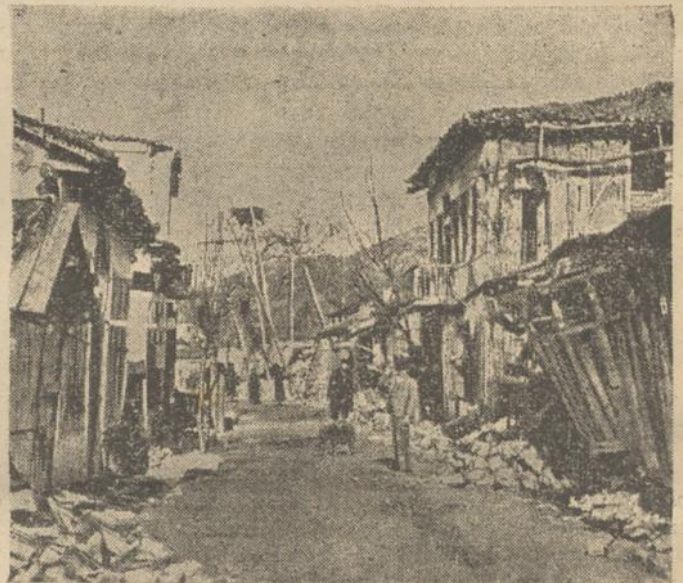
Eine fast völlig zerstörte Straße der Ortschaft Pirewo, die besonders schwer betroffen wurde. Bei dem Erdbeben kamen bekanntlich etwa 200 Menschen ums Leben.
