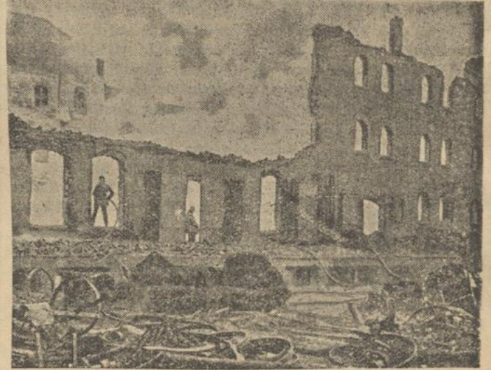
Unser Bild zeigt eins der bis auf die Umfassungsmauern niedergebrannten Fabrikgebäude.
