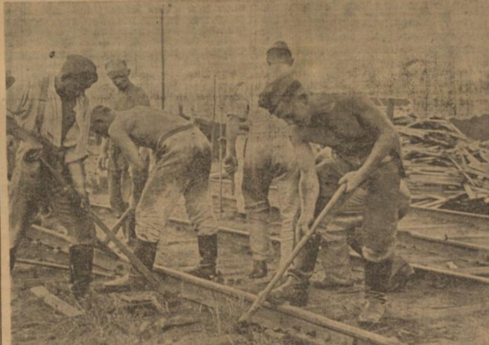
Der Nachschub darf nicht stocken, deshalb werden die Gleise auf deutsche Spurweite gebracht (PK. Mahle)
