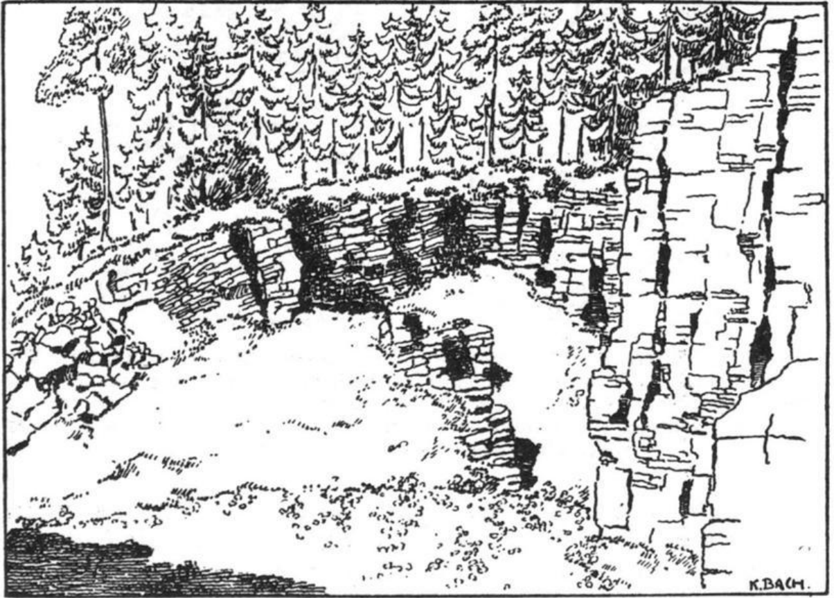
Bild 99: Städtischer Steinbruch an der Mözinger Steige. Trochitenkalk. Rechts noch in ursprünglicher Lagerung, wenn auch stark zerklüftet. Links starke Verstörungen infolge Auflösung im drunter liegenden Salzgebirge. Die Schichten hängen gegen das Tälchen. Spalten mit Bohnerz und Geröll (unter dem Busch).
