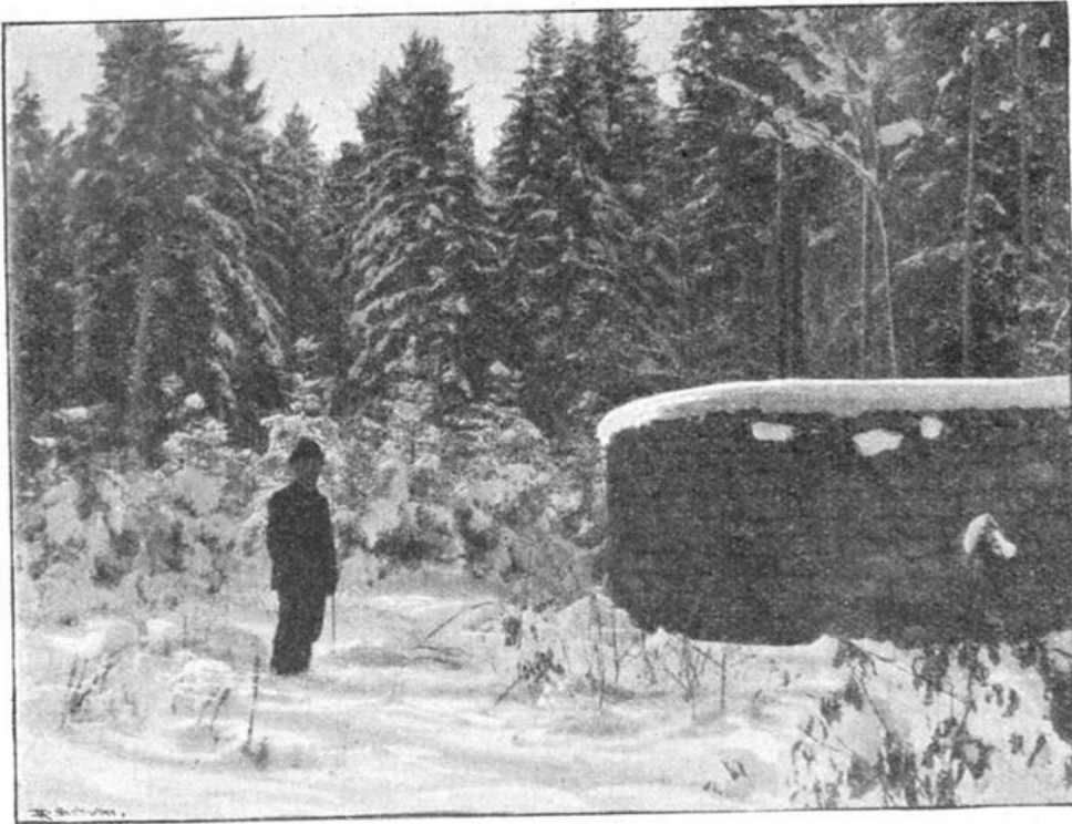
Schafjott bei Calw. (2 m hohe Rundmauer mit Staffelaufgang.)
