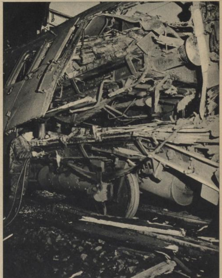
MÜSSEN: In dichtem Nebel überfuhr ein nach Hamburg fahrender Personenzug auf der eingleisigen Strecke das Haltesignal und stieß mit einem Güterzug zusammen. Der erste und der zweite Wagen des Personenzuges wurden bei dem Zusammenprall vollständig ineinandergeschoben. In stundenlangem, mühevoller Arbeit konnten vier Tote, drei Schwer- und 14 Leichtverletzte geborgen werden.
